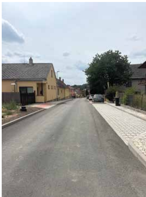
Výsledek rekonstrukce ulice Palackého
