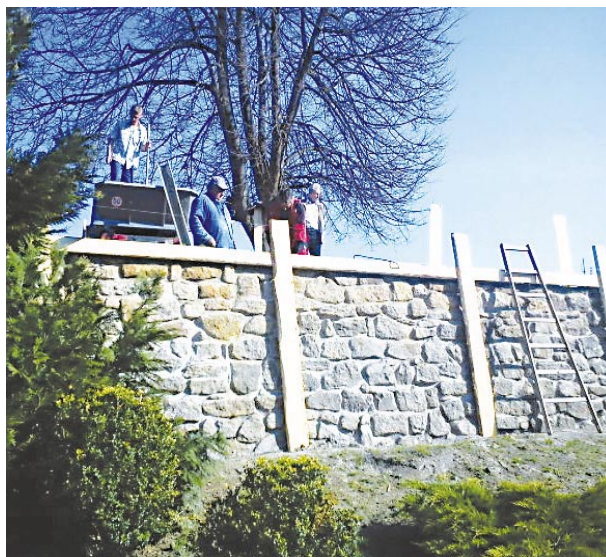
Oprava opěrné zdi
