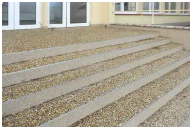
Rekonstrukce schodů na respiriu - kamenný koberec
